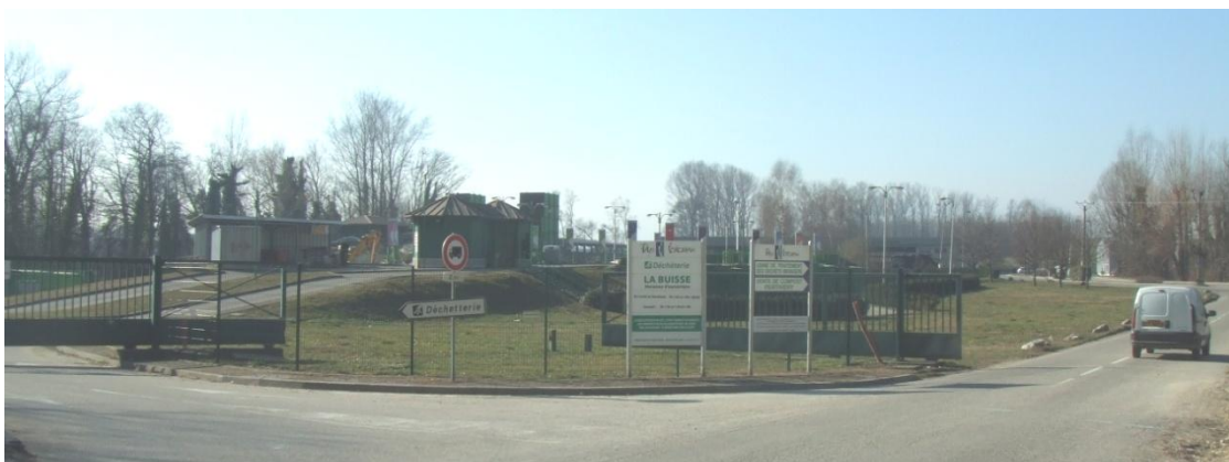
Vue sur l'entrée du Site Ecologique du Pays Voironnais
